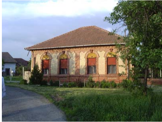
jellegzetes téglahomlokzatú lakóépület
